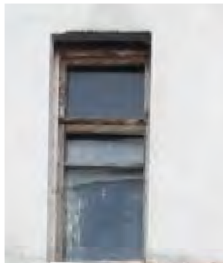
Аутентичное заполнение оконных проемов на фронтоне здания №4
